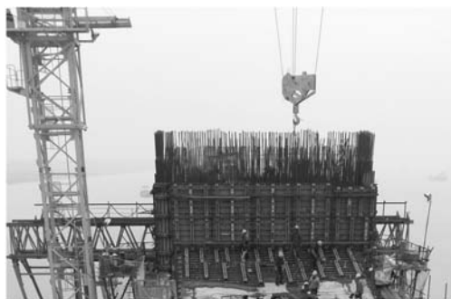
图 5 第 9 节模板安装
