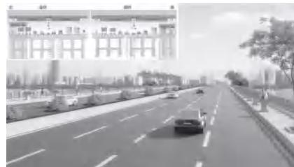
吴中路人行天桥包含桩基 16 根、承台 7 个、梯台 4 个、墩柱 7 个、钢箱梁及附属工程等。
