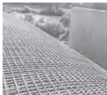
半圆拱圈真圆度成型技术保障了夏桥河桥拱圈真圆度，确保了拱圈的成型质量。
