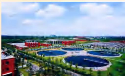
**工程概况：**大东湖核心区污水传输系统与北湖污水处理厂及其附属工程位于武汉市武昌区、洪山区、东湖风景区、青山区，投资额约75.8亿，建设内容包括：（1）1座提升泵站、3座污水预处理站；（2）直径D3000-D3400mm、长17.5km的盾构+二衬主隧，直径2-D1650mm、长1.7km的顶管支隧；（3）深46m的深隧泵房、粗格栅、细格栅及曝气沉砂池、总配水井、A/A/O生物反应池、二沉池、膜格栅间、MBR膜池、MBR鼓风机房、高效反应沉淀池、深床滤池及接触消毒池等建、构筑物及相关配套工程。
