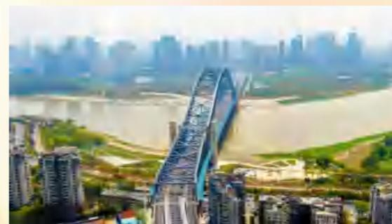
**工程概况：**江汉七桥（解放大道~汉阳大道）工程是武汉市城市规划的第七座市区跨江桥梁。工程跨越武汉市汉阳、硚口两个行政区，位于江汉六桥与江汉二桥之间，北起解放大道南接玉龙路，主线全长2754米，其中跨江主桥长672米，为三跨钢桁系杆拱桥，引桥采用标准跨30m或40m的预应力混凝土连续梁，跨堤、跨路节点采用钢箱梁。
