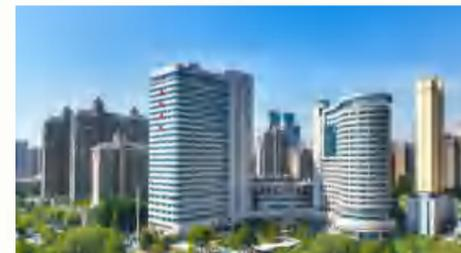
**工程概况：**新建医技综合大楼项目（武汉市普仁医院）工程位于武汉市青山区本溪街，投资额约4.6亿，建筑高度99.35m，总建筑面积71528.11 $m^2$ ，地上26层，地下3层，其中地下室部分21609.99 $m^2$ ，地上部分49973.12 $m^2$ 。共分为地下停车库、设备机房、检查室、康复保健、实验五大功能区，包括住院病房、屋顶停机坪。
