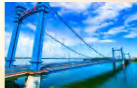
**承建单位：**襄阳庞公（凤雏）大桥工程位于襄阳市，连接樊城与襄城，横跨汉江，投资额约11.3亿，为市政桥梁工程，线路总长2603.863m，桥梁总长2023.038m，全线由南、北引桥及跨江主桥三部分组成，主桥为三塔两跨钢混结合梁悬索桥，主跨2 $\times$ 378m，按双向六车道、城市主干道设计。该项目是新冠疫情后湖北省首座建成通车的跨江大桥，建成后的庞公（凤雏）大桥有效提升了区域综合交通能力，促进了襄阳的经济发展，其独特的外观造型与两岸一洲完美融合，成为襄阳的城市名片和网红打卡地。
