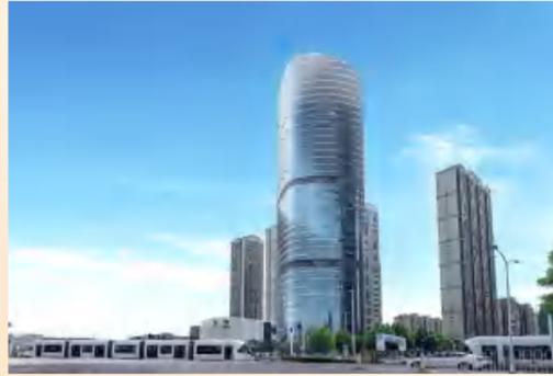
**工程概况：**武汉泛悦城二期二标段工程位于武汉市东湖高新区，北临珞瑜路、华中科技大学。本工程总建筑面积13.4万 $m^2$ ，包括1栋超高层写字楼、3栋多层商业楼及地下室。总投资19.23亿元，工程建安费3.8亿元。T2号写字楼地下2层，桩筏基础，地上33层，框架核心筒结构，建筑总高度177.70m（其中143.10m钢筋混凝土结构、34.6m钢结构）。3栋商业楼地下3层，独立基础，地上3层，框架结构，建筑高度为23.80m。本工程采用TOD一体化城市设计方案，有机融合商业、办公、居住、园林等多元复合功能业态。
