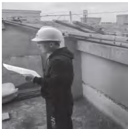
图：高处作业安全检查
