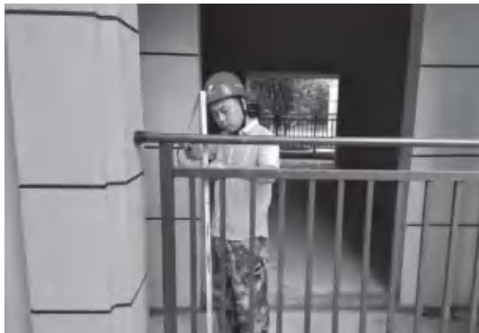
图：防护栏杆安装质量检查
