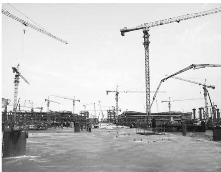
5月10日下午5时，随着“天泵”车细长的臂管吐出最后一捧混凝土，标志着全球最大会展中心——深圳国际会展中心项目北区中廊区域冲出地平线，28万平方米地下室结构施工全面封顶。
